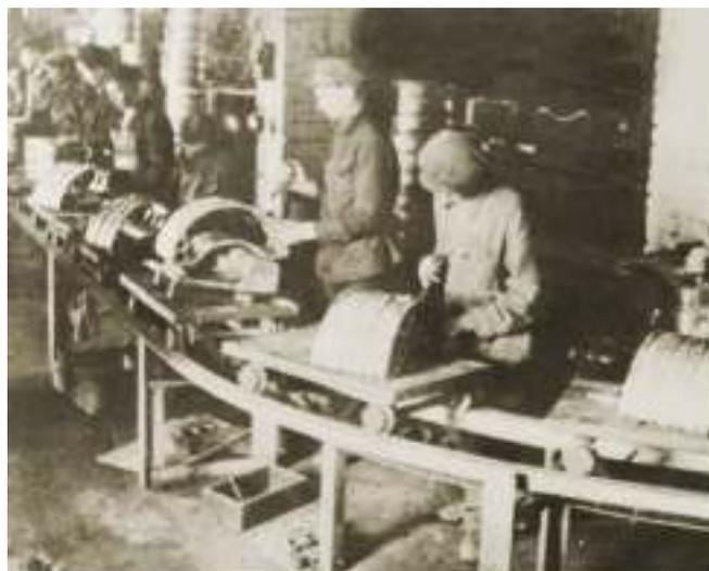
Конвейер для сборки радиаторов
